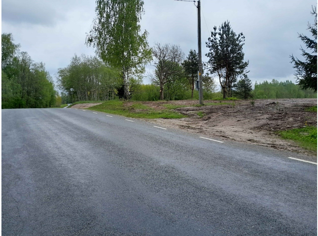
Joonis 2. Kõdimäe kinnistu juurdepääs(ud) ning elektri liitumiskilp, foto kohapealt 23.05.2025. Esiplaanil endile likvideeritud ristumiskoht, keskel elektri õhuliini mast koos liitumiskilbiga ning tagaplaanil uus seadustatav riigitee ristumiskoht.
